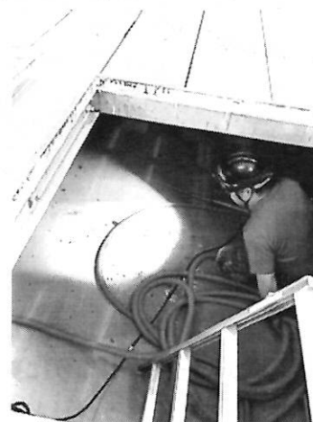
床下に潜る清掃作業員
